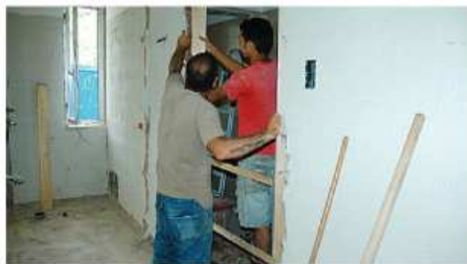
Lavori di ristrutturazione edilizia
